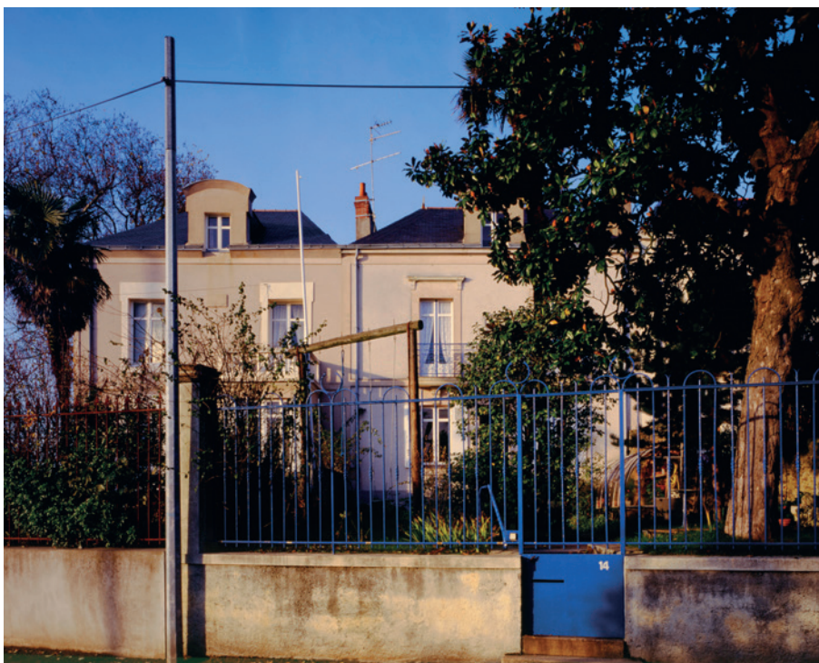
▲ La rue Bruneau à Trentemoult présente un bel alignement de maisons de cap-horniers typiques (Ville de Rezé © P. Ruault)
