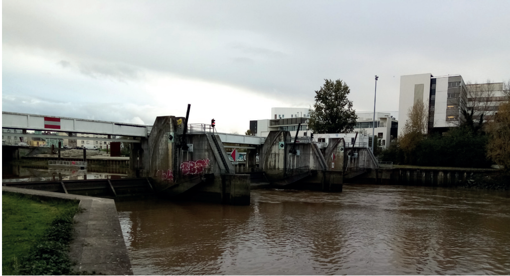
Barrage sur la Sèvre (Photo I. Impinna)
