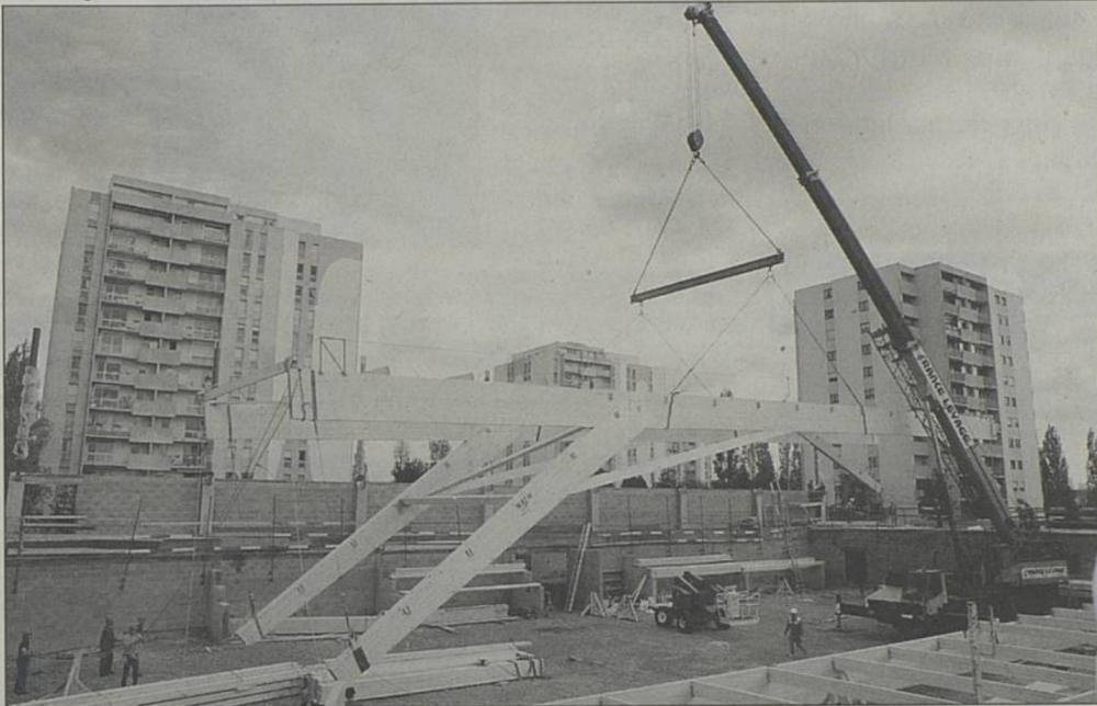
Le gymnase sera reconstruit à neuf. L'assemblage, le levage et la pose de la charpente ont été effectués mi-octobre. Livraison prévue pour l'été 98.
