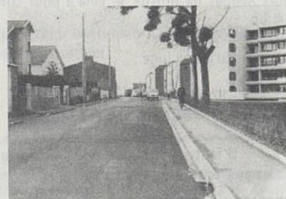
La rue Emile Zola après réfection
