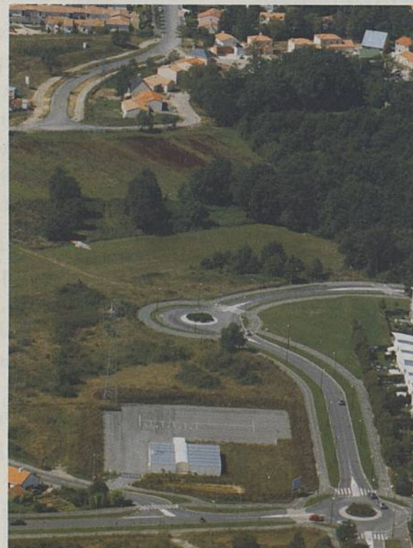
La nouvelle voirie va relier les boulevards Spaak et Monnet.
