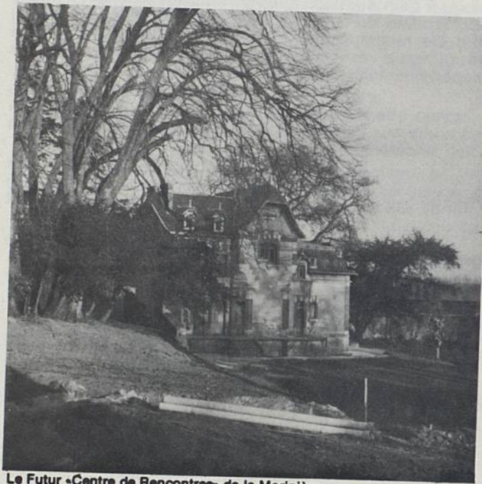
Le Futur «Centre de Rencontres» de la Morinière
