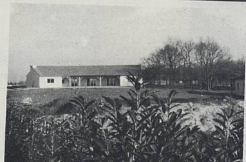
Le centre aéré et les salles de Réunions de la Robinière
