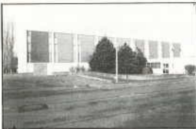
Gymnase des cités unies et la salle de l'O.M.S.
