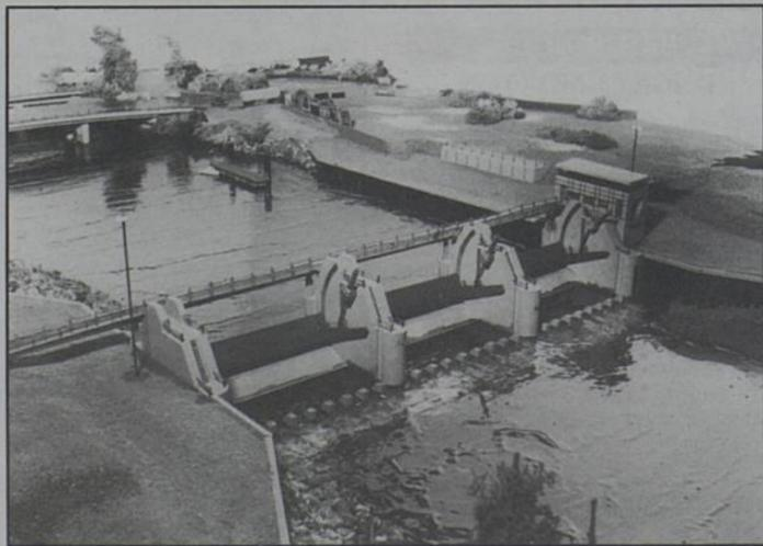
Deux ans de travaux, cinq entreprises, 6 000 tonnes de roches, 6 800 m<sup>3</sup> de béton, 1 000 m de pieux métalliques, 316 tonnes de planches, 30 000 m<sup>2</sup> de terrassement et 49,2 millions de francs, voilà les chiffres !
