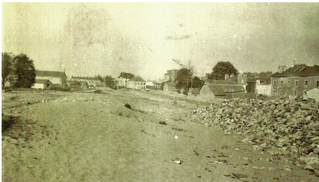
Avenue de la Libération en construction avant la guerre, achevée après 1947
