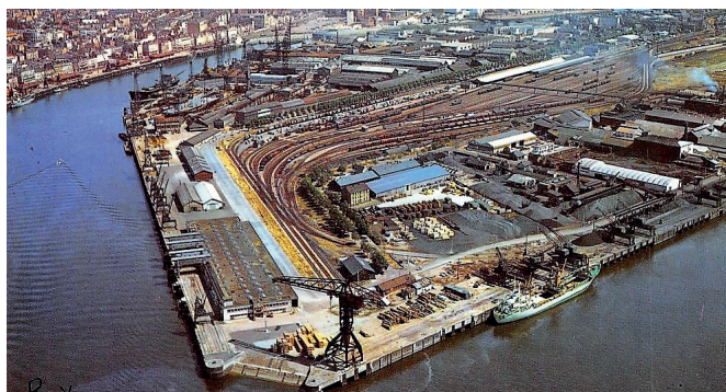
Ile de Nantes – les chantiers et le quai Wilson au sud
