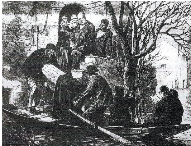
Enterrement par jour de crue dans les îles de Rezé (coll. Chapeau)
