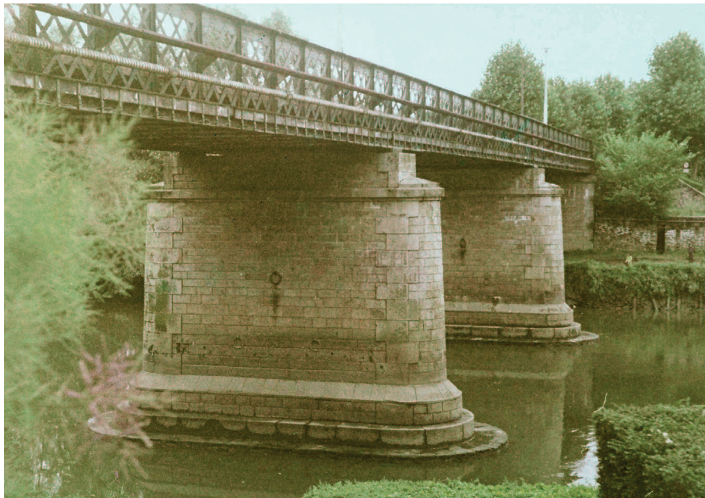
Pont de la Morinière. A.M. Rezé
