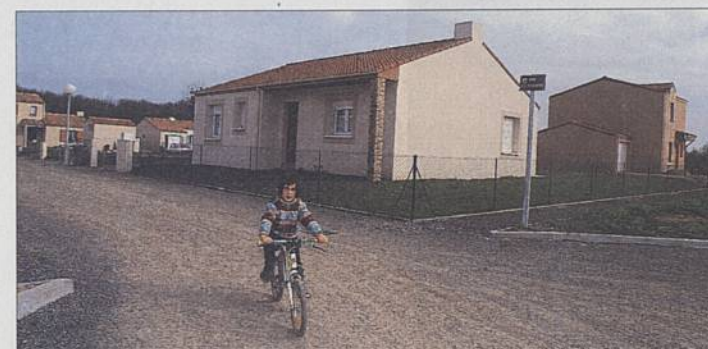
La rue R-L Stevenson dans le lotissement du Clos des Îles.
