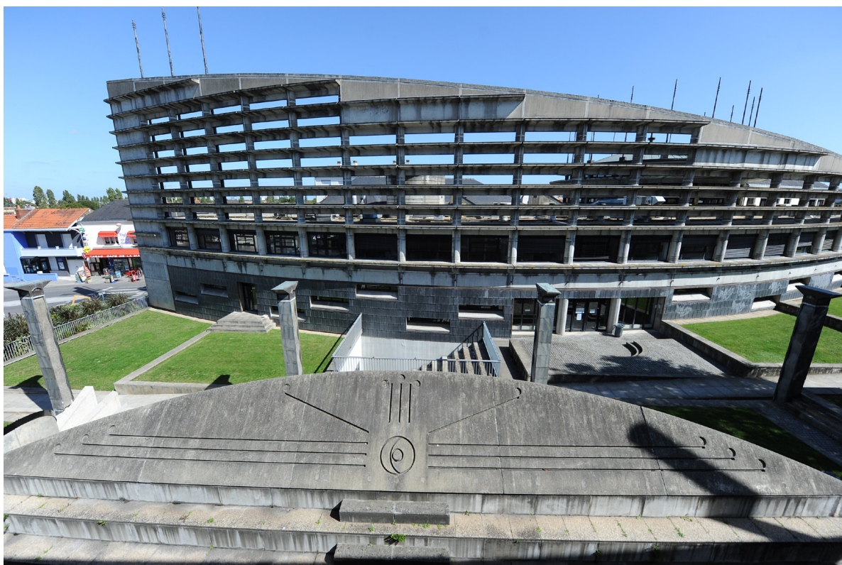
Fresque de la chaufferie- Cliché T. Mezerette (Mairie de Rezé)
