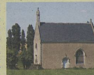
Les fouilles réalisées au XIX e siècle sur le site gallo-romain de la chapelle St-Lupien avaient montré l'existence d'un vaste édifice possédant des bains ainsi qu'une nécropole.
