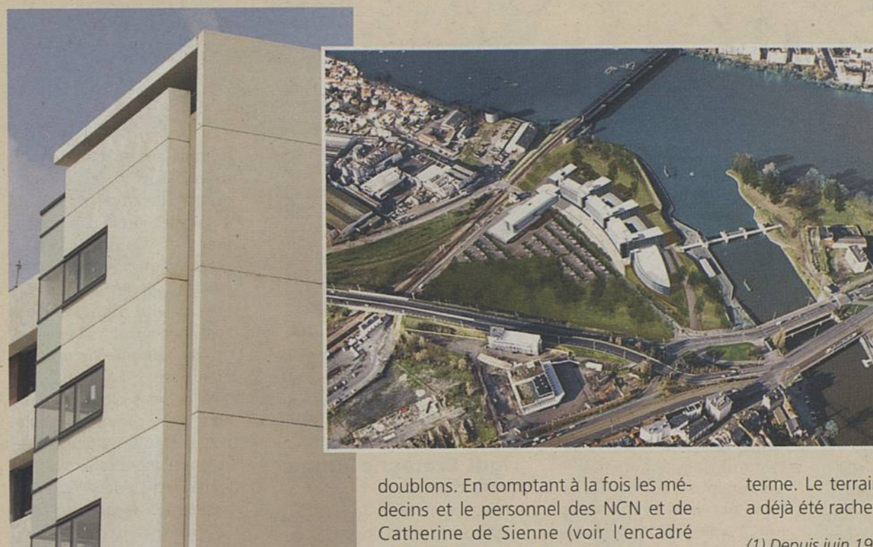
Vue du site du Confluent une fois finalisée l'installation des NCN et du Centre Catherine de Sienne.
