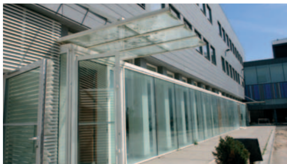
Quatre ans de travaux de restauration.
