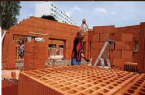
La crèche de Port-au-blé a été construite en bio briques, matériau isolant.
