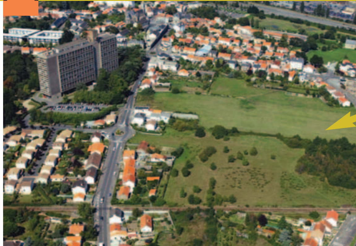
Le site des Bourderies accueillera, outre le foyer (à droite sur la photo), un pôle de formation supérieure dans le domaine social.
