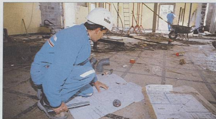
Travaux de rénovation au groupe scolaire Château-Nord.
