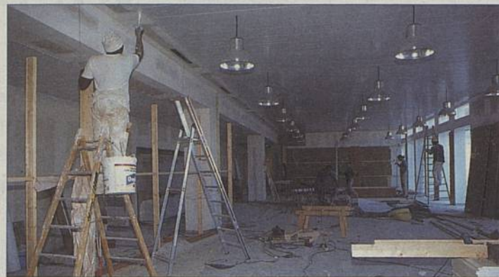
La salle de restauration du collège sera bientôt rénovée.
