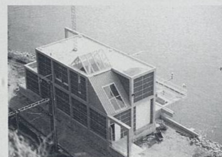
PRISE D'EAU EN LOIRE
