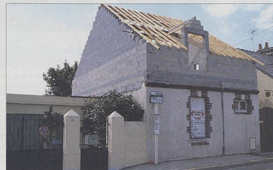
« On observe les modifications visibles de la chaussée », précisent les membres de la commission communale.
