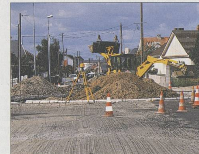
Un giratoire « classique », comme celui aménagé récemment à l'angle des rues Cadoire et Jouaud : 1,108 MF, dont 293 568 F pour la réalisation de la chaussée, 166 709 F pour l'alignement des clôtures, 84 575 F pour l'effacement des réseaux (EDF et France Télécom), 11 346 F pour les espaces verts (travaux préparatoires), 8 887 F pour les panneaux de signalisation verticale, 5 660 F pour les travaux de marquage au sol.
