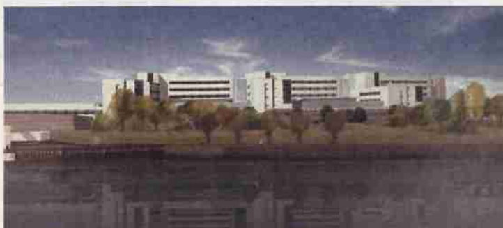
Les Nouvelles Cliniques Nantaises et le Centre Catherine de Sienne sont installés en confluent de la Loire et de la Sèvre.
