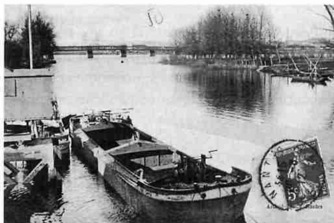
En arrière-plan, le pont de la Contrition (chemin de fer)
