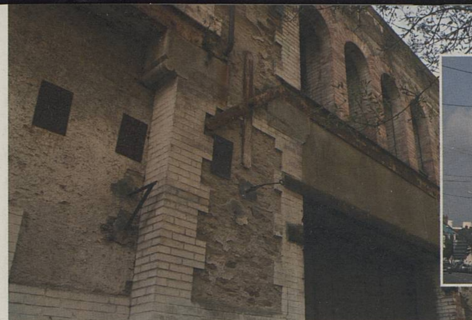
Afin de permettre la réhabilitation des anciennes Charcuteries de Bretagne et de préserver ce site remarquable, une interdiction de démolir a été prise.
