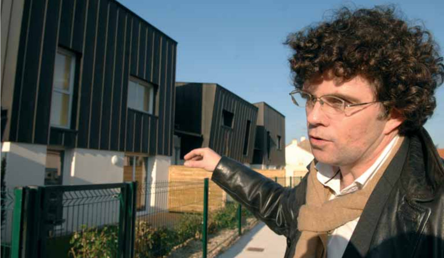
Sous ce bardage en zinc, une isolation par l'extérieur pour améliorer la performance thermique.
