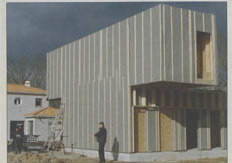
Les premières « maisons innovantes » en cours de construction se mélangent aux maisons plus traditionnelles du lotissement.
