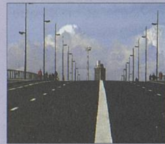
Le pont des Trois continents à la Tour Bretagne, siège de l'Agence de développement économique de l'agglomération nantaise, la Loire n'est plus une frontière.
