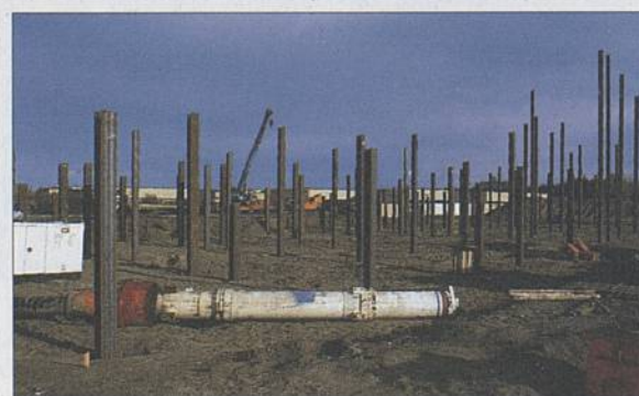
Près de 400 pieux métalliques seront ancrés dans la roche.
