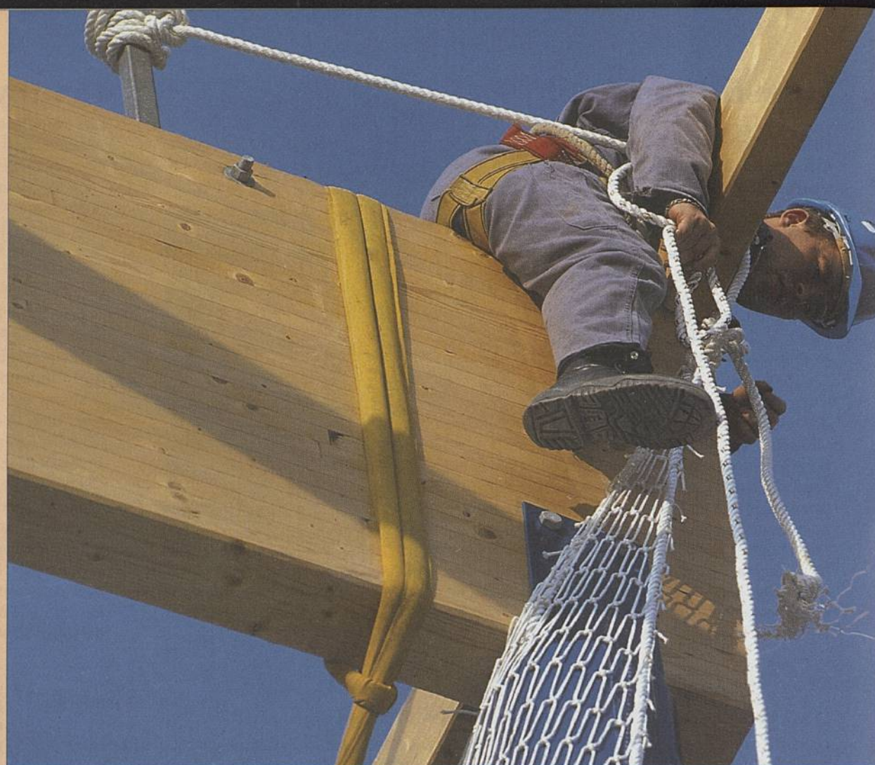
Opération délicate, l'ajustement de la charpente, réalisé par les stagiaires et compagnons du chantier Euronef, s'est faite... au centimètre près.
