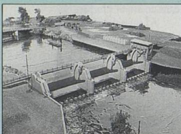
Mise en service du barrage-écluse sur la Sèvre en 1992. Commandé par des automates, son fonctionnement original sera unique en Europe. Piétons, poissons et bateaux passeront l'ouvrage sans difficulté. Son utilité : maintenir le niveau d'eau, réduire les remontées de vase, stabiliser les berges et favoriser le développement du tourisme et des activités de loisirs.
