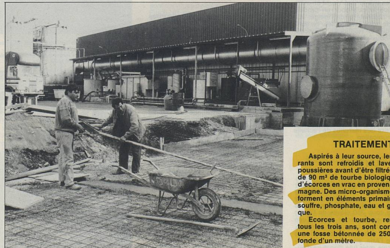
La construction de la fosse désodorisante.
