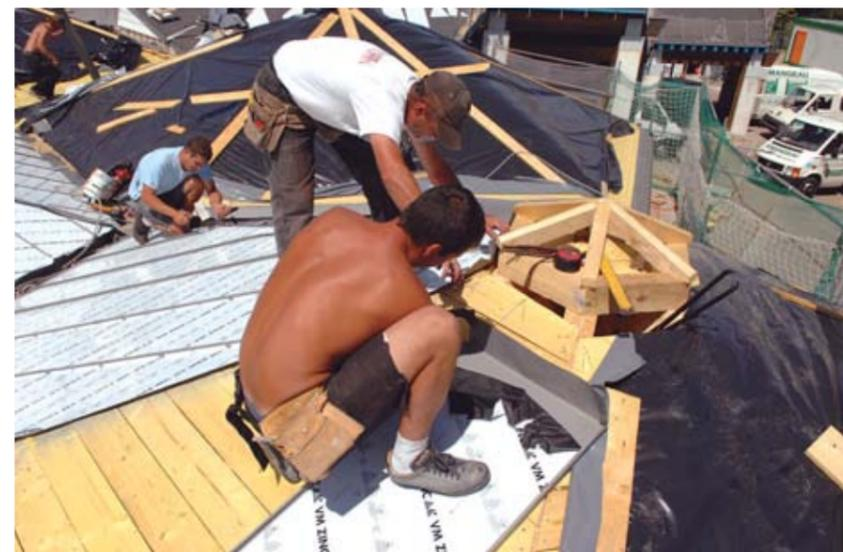
Le toit va être revêtu d'une surcouverture en zinc de 1500 m<sup>2</sup>.
