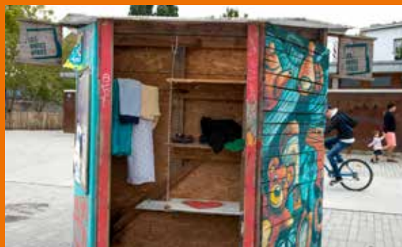
Construction d'une boîte à dons, le 27 janvier.
