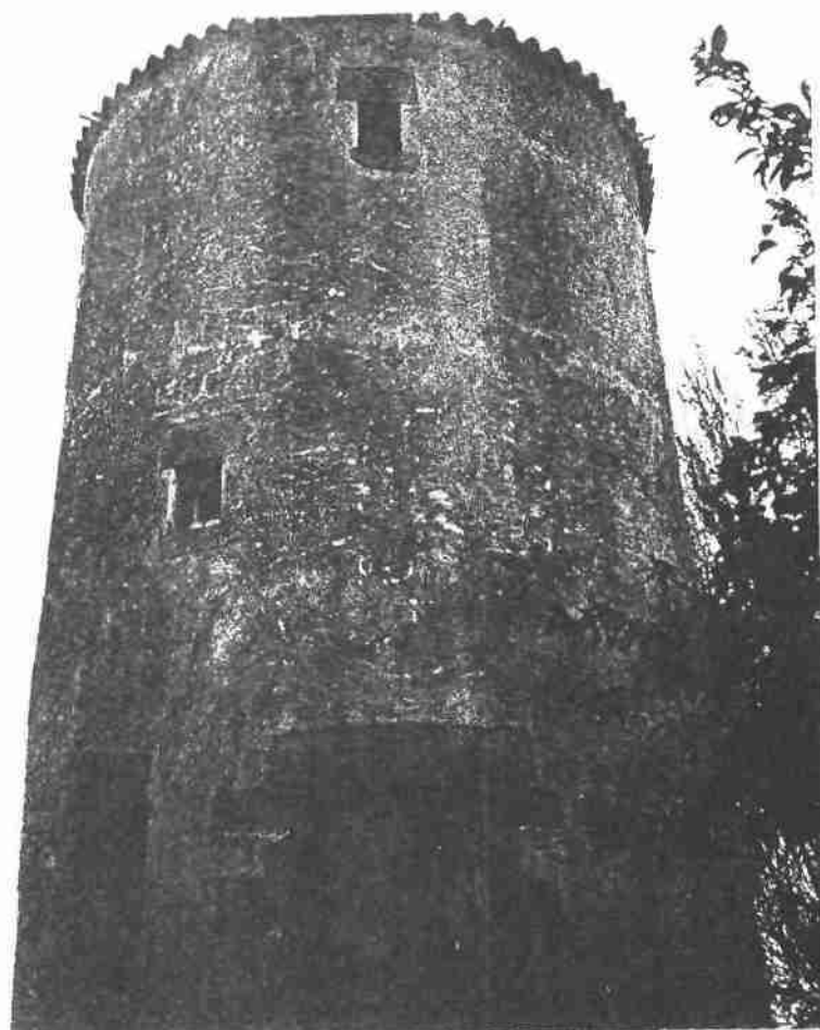
Le moulin des Gâts aux Trois Moulins
