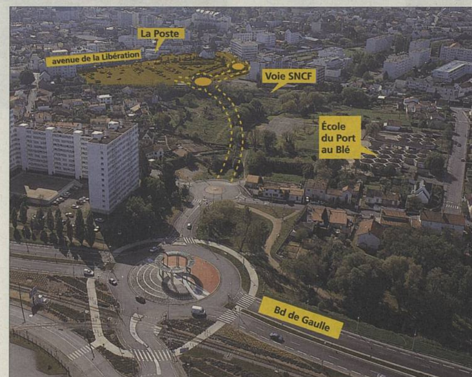
La rue André Malraux (en pointillé) reliera le giratoire Raballand à la place du 8 mai réaménagée.
