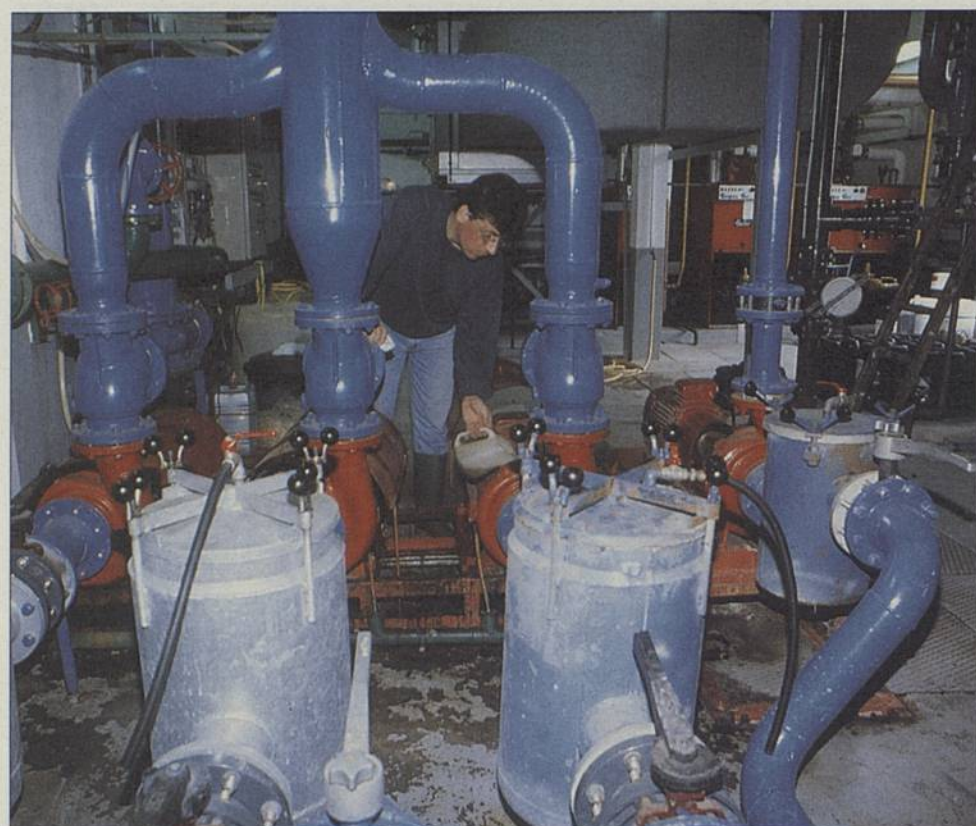
Un enchevêtrement de tubes et tuyaux pour le plus grand plaisir des baigneurs.
