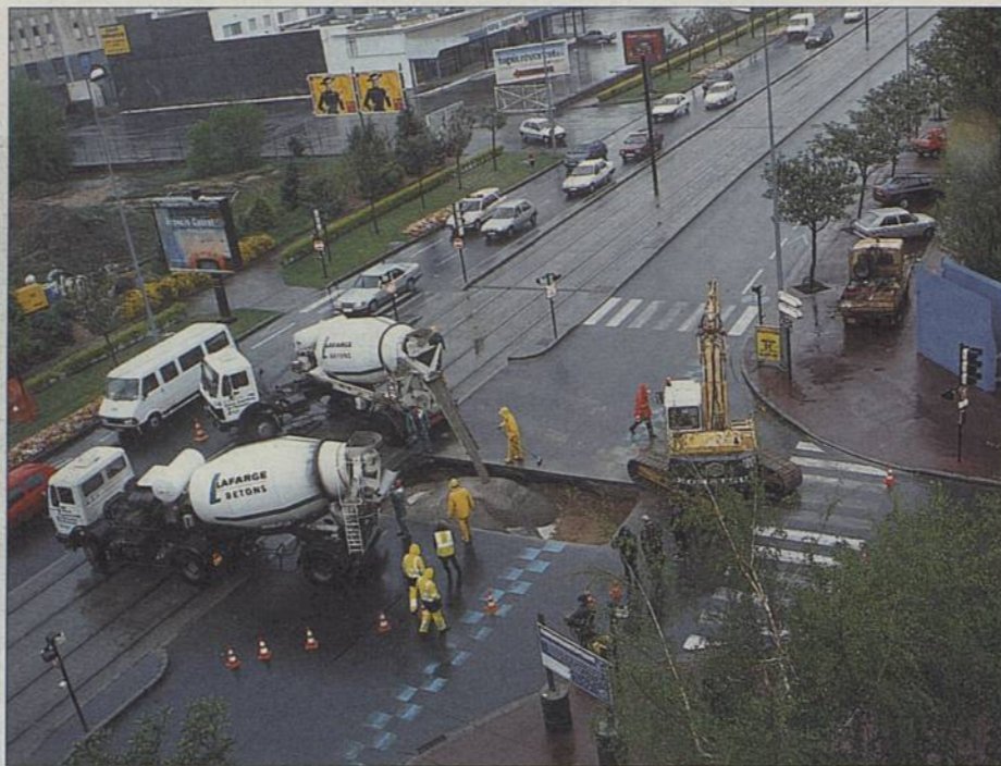
Il a fallu attendre plusieurs heures avant que le béton ne se soit entièrement solidifié.
