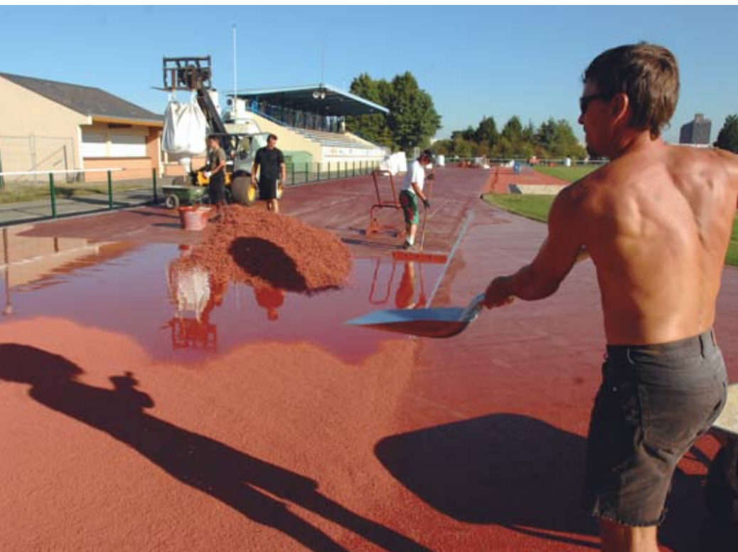
En septembre, le revêtement était en cours d'achèvement.
