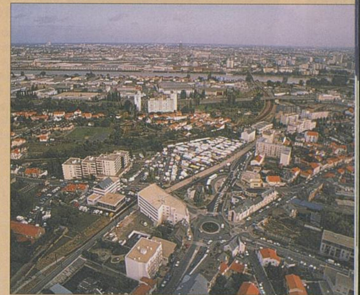
Pont Rousseau, un quartier en mutation en même temps qu'un pôle tertiaire et médical qui rayonne sur le département.
