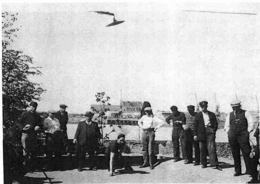
Rezé - La Haute-Ile Le jeu de boules , au bord de la Loire, en 1938 De l'autre côté du fleuve, le quai Wilson avec ses grues
