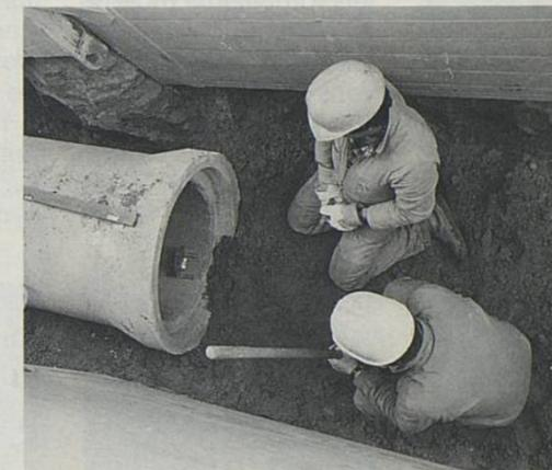
◀ **Assainissement** Derniers travaux pour boucler l'assainissement de la Basse-Ile : la pose d'un clapet qui empêche la remontée des eaux. Coût : 90 000 F.
