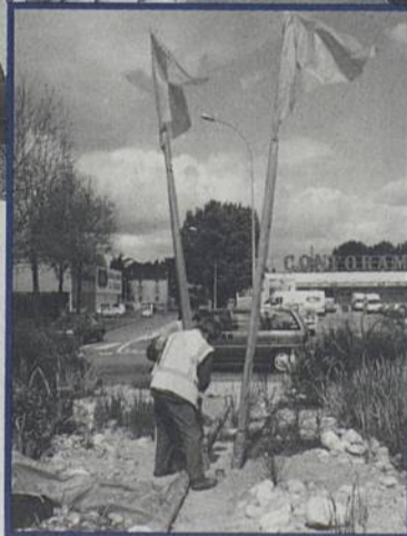
La pose des mâts dans les quartiers a été réalisée mi-avril.
