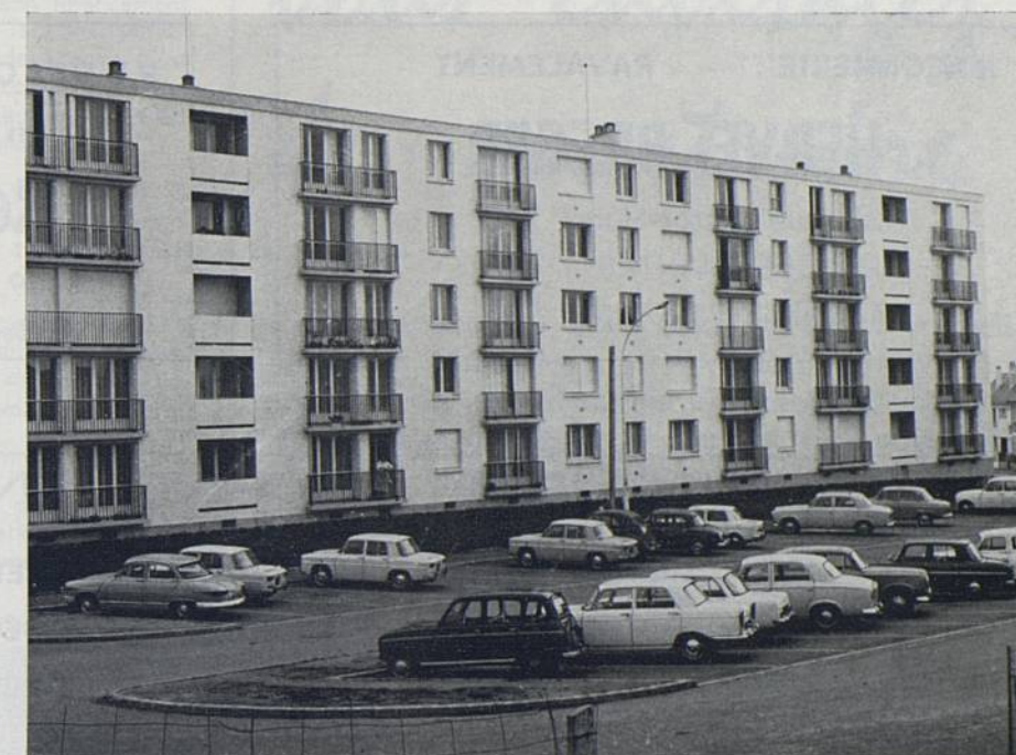
Immeuble de la S.E.M.I.
