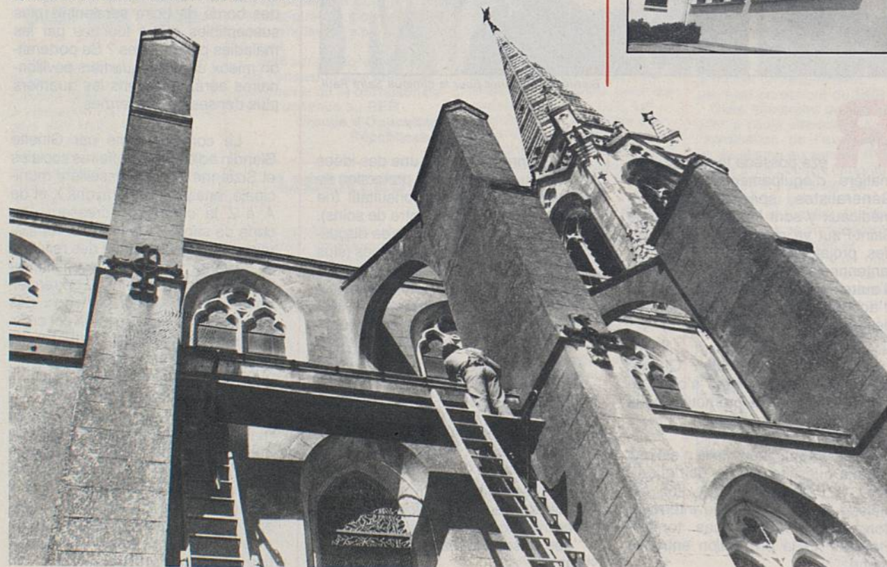
Eglise Saint Pierre : réfection de la couverture.
