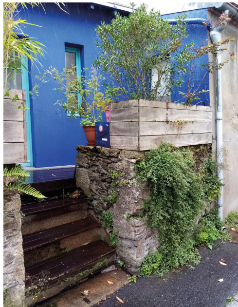
La maison rénovée des parents de Ginette Blandin, le puits se trouvait derrière le muret. (Cliché I. Impinna)
