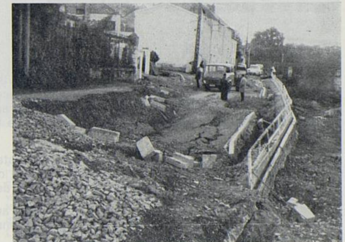
Effondrement du quai Léon-Sécher
