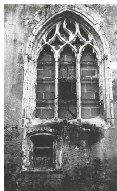
Baie orientale avant restauration
