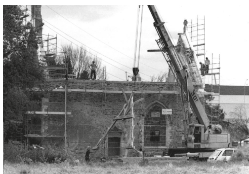
Restauration de la toiture
