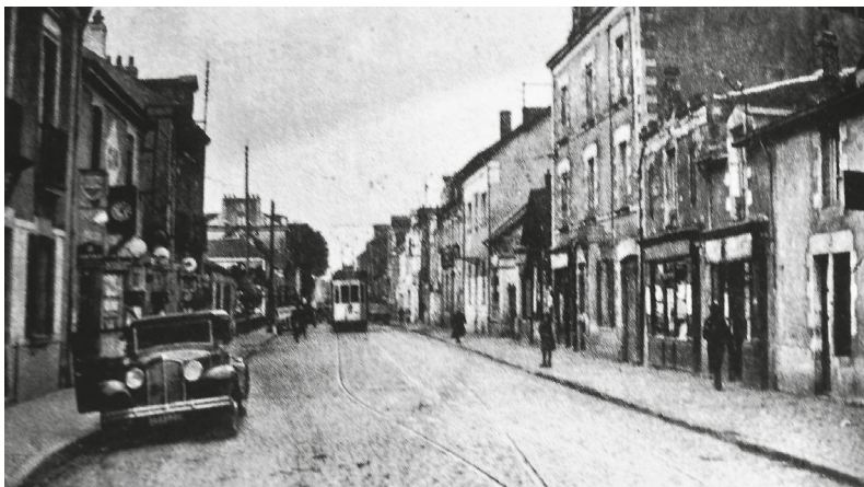
2 rue Jean Jaurès. À droite, au 1 er étage se trouvait l'appartement de J.C Caillard
